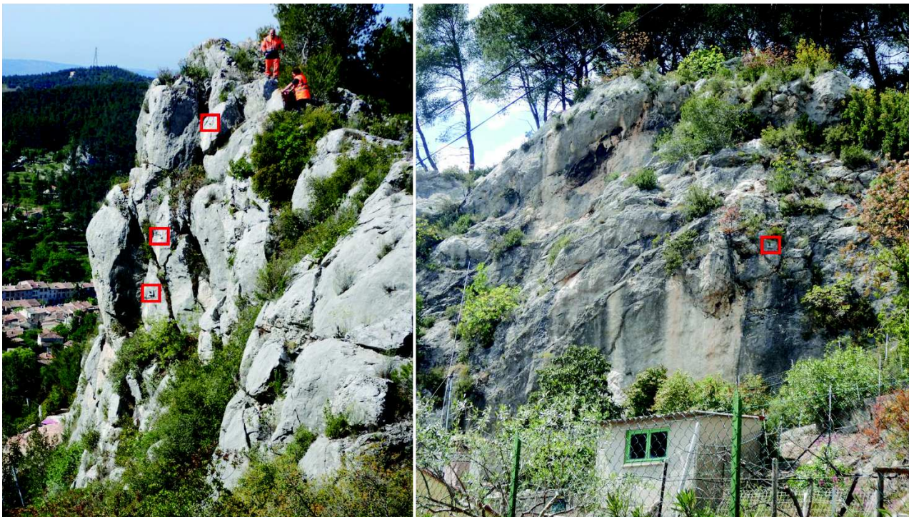
Illustration 9 : exemples d'ancrages de confortement observés sur le secteur 1 (à gauche) et le secteur 2 (à droite)
