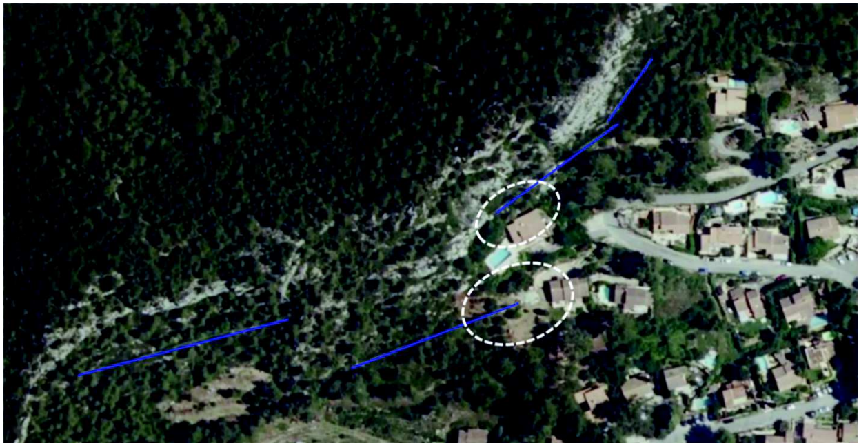
Illustration 6 : localisation des écrans pare-blocs au pied de la falaise de Sainte-Croix (source : Géoportail).
